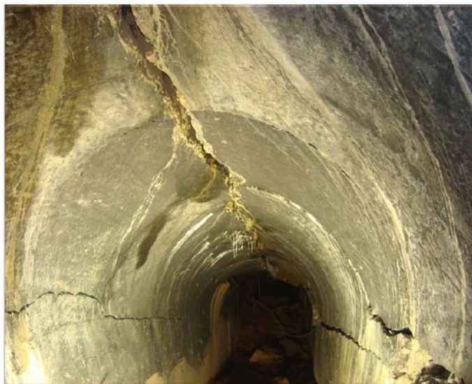
Galeria de Inspeção antes da intervenção
